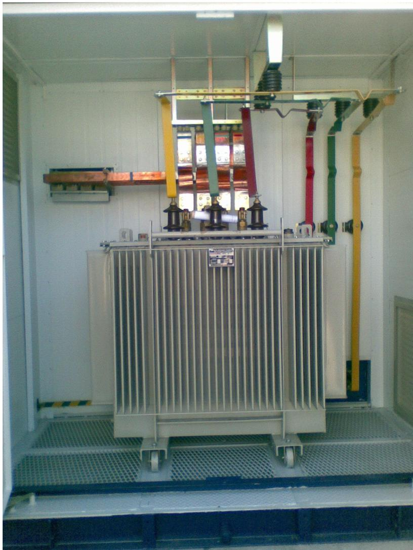
**Рисунок 2 – Трансформаторный отсек**
