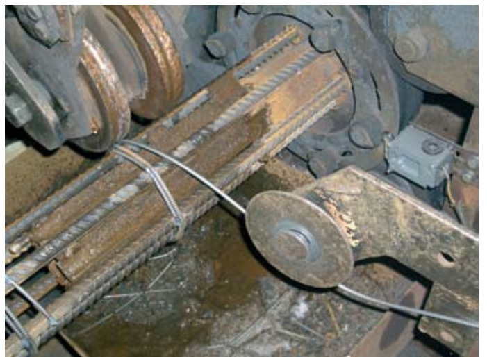
Рисунок 9 Сварка продольной и поперечной арматуры каркаса.
