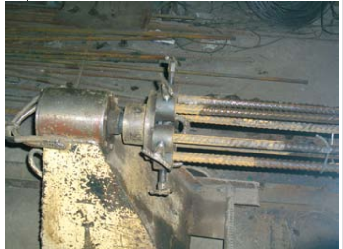
Рисунок 8. Крепление продольной арматуры к передвижной тележке
