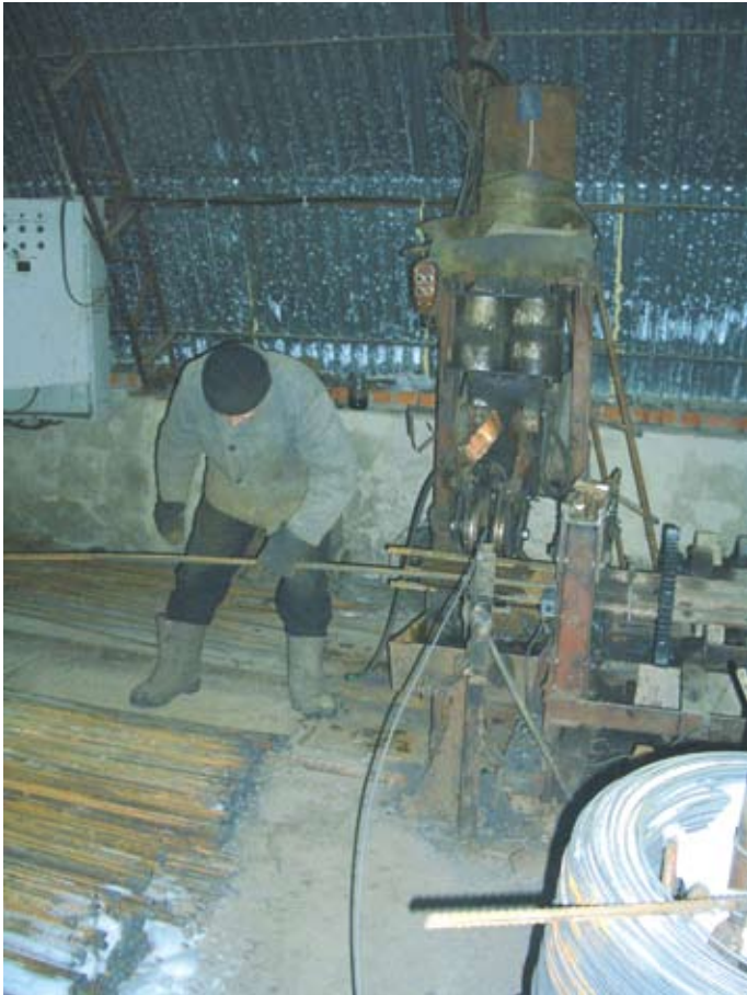
Рисунок 6. Установка вручную продольную арматуру каркаса
