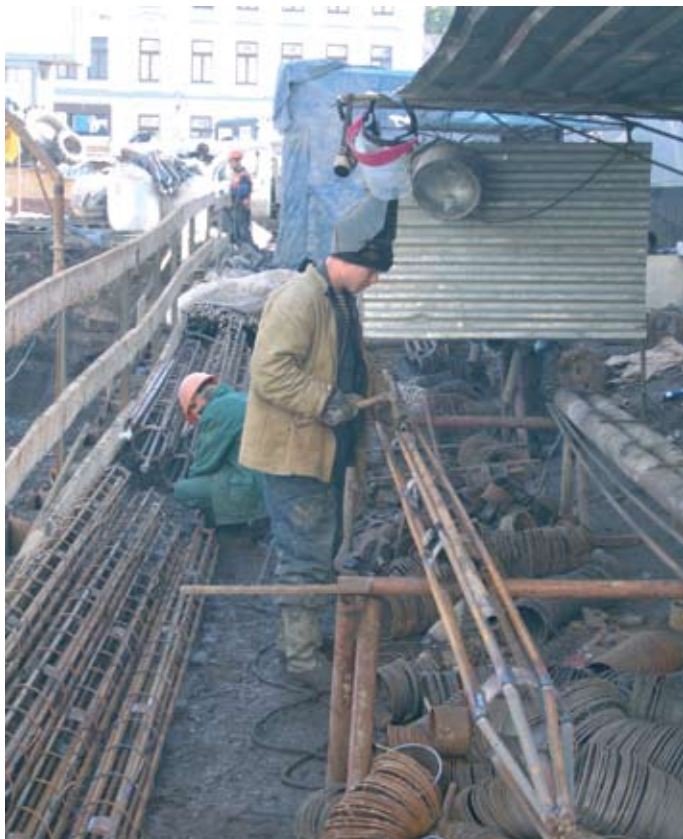
Рисунок 1 Изготовление каркасов свай на строительной площадке.
