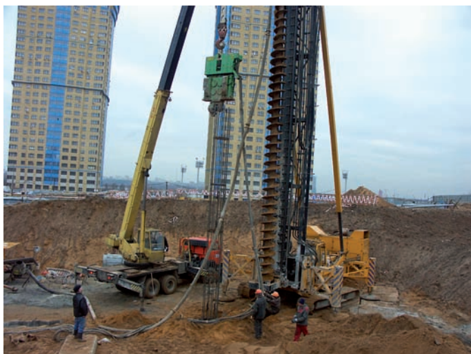
Фото 2. Погружение арматурного каркаса в скважину, заполненную бетонной смесью
