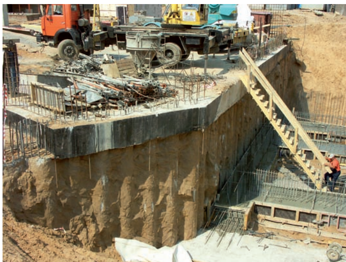
Фото 3. Ограждение котлована «стена в грунте» из бурокасательных буронабивных свай диаметром 800мм при возведении комплекса зданий и сооружений Московского Государственного Института Электроники (МИЭМ).
